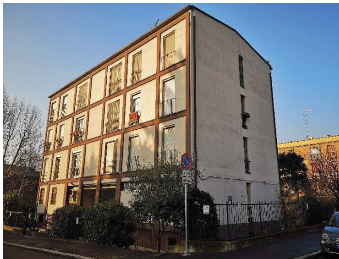
Casa prefabbricata a quattro piani (arch. Gabrielle Mucchi) in via Goya, con struttura "sistema Gaburri" Archivio Bottoni , Op. 4-3;
