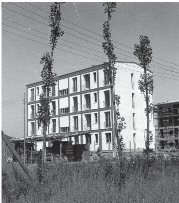
Casa prefabbricata a quattro piani (arch. Gabrielle Mucchi) in via Goya, con struttura "sistema Gaburri" Archivio Bottoni , Op. 4-3;
